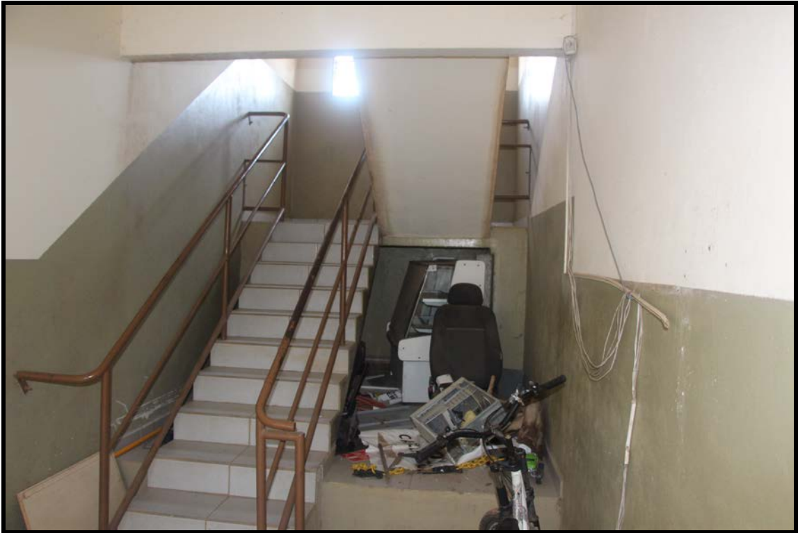
Interior da construção assobradada
